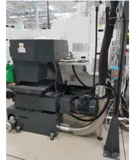
Calata dell'impianto pneumatico con trituratore Down conductor of the pneumatic system with shredder Auswurf der pneumatischen Anlage mit Spänebrecher
