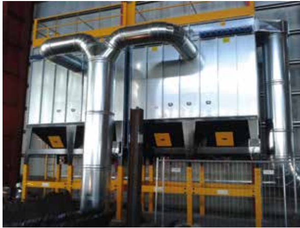
Filtri a maniche per alta temperatura (250°C) Bag filters for high temperature (250°C) Filter mit Hülse für hohe Temperatur (250 °C)
